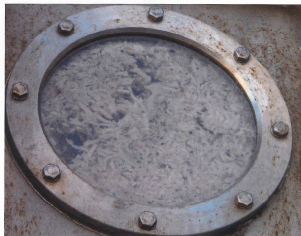
Fig. 5: Vuoti di polpa nel gambale di alimentazione / Empty spaces without spent pulp in the feeding hopper
